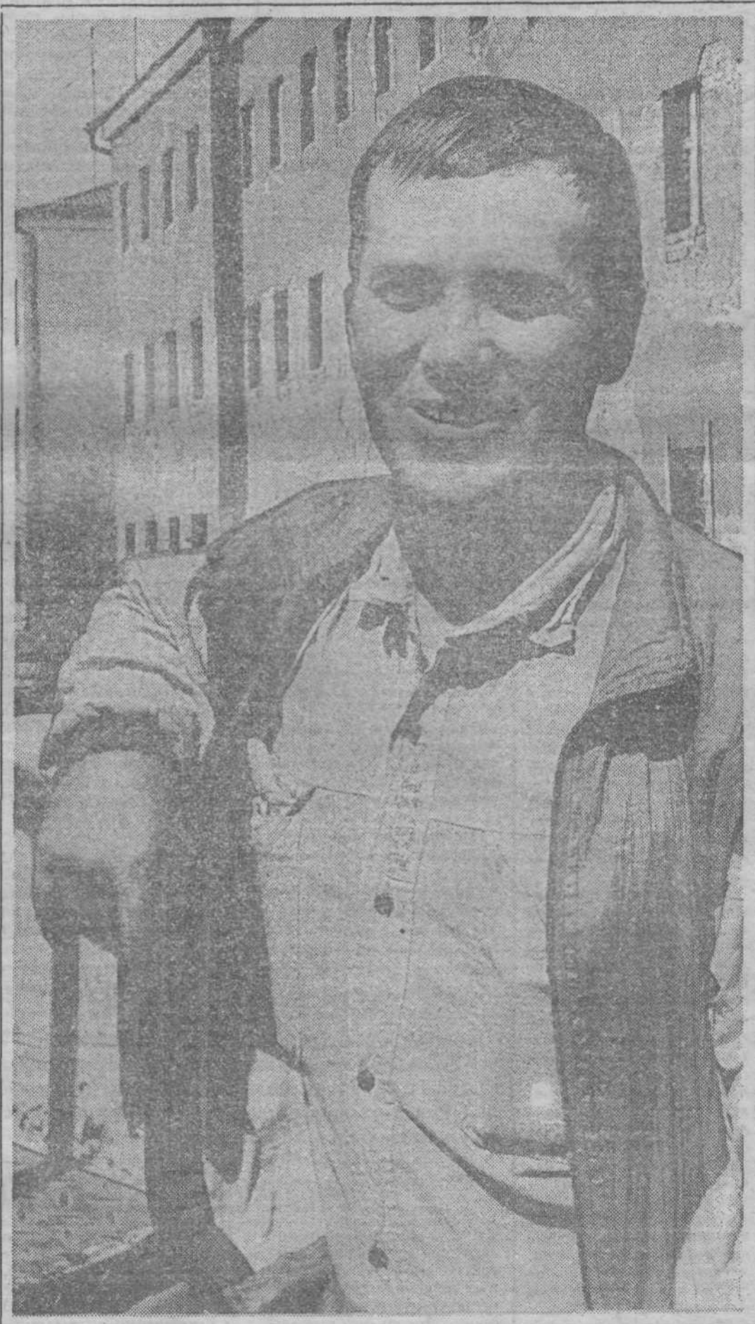
В городе ведутся дорожные работы. Ремонтируется старое покрытие. С наступлением лета начали заменять асфальт и на Кузнецком проспекте, по которому особенно интенсивный поток транспорта. На снимке вы видите ИЛЮЮ ВАСИЛЬЕВИЧА КОЗИРЕВА, машиниста катка из СДРСУ-8. Дорожником он — десять лет. Из них два года работает на новой импортной технике, делая наши дороги прочнее и глаже. Фото Евгения ЛАНКИНА.
