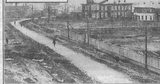
Улица Дзержинского. Начало строительства кинотеатра «Москва».
