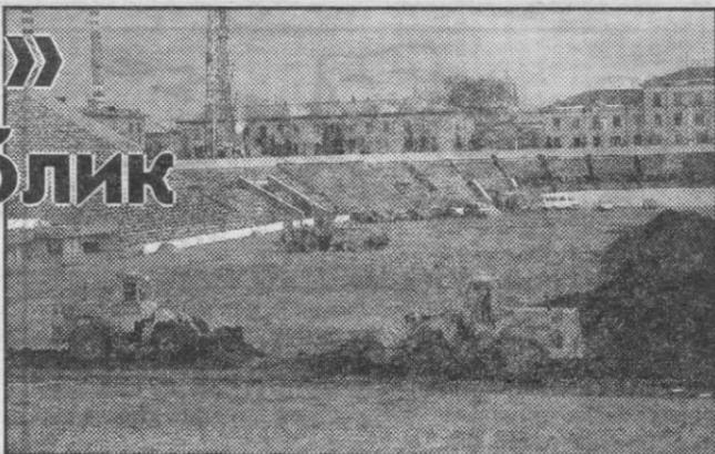
На первом этапе были проведены вскрышные работы: мощные бульдозеры в считанные дни сняли 40-сантиметровый верхний слой грунта. Использованный грунт пошел на благоустройство областного центра. А вообще глубина вскрыши достигнет одного метра.
