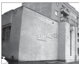
ул. Патриотов, 36 S=134,4 кв.м., (подвал)
