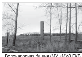
Водонапорная башня (МУ «МУЗ ГKB № 11» и ул. Вахрушева, 2). Общая площадь 21,2 кв.м.
