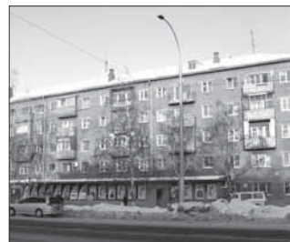
ул. Терешковой, 42 S=631,9 кв.м., (подвал 363,6 кв.м)
