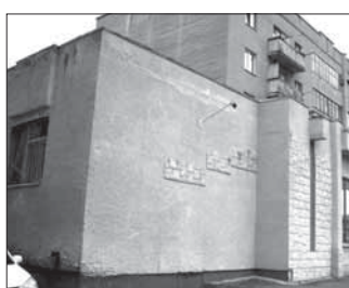
ул. Патриотов, 36 S=134,4 кв.м., (подвал)
