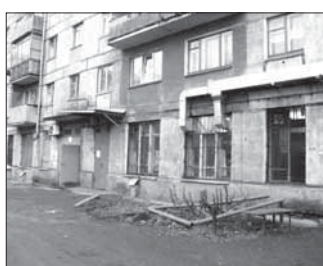
ул. 40 лет Октября, 23 S=140,3 кв.м., (подвал)
