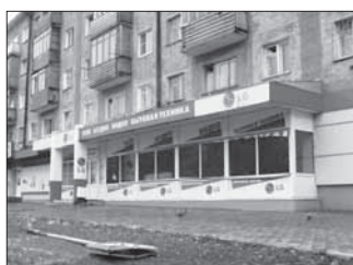
ул. Волгоградская, 23 S=94,3 кв.м., (подвал)
