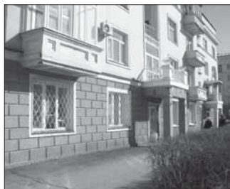
ул. Орджоникидзе, 5 S=291,3 кв.м., (подвал 280 кв.м)
