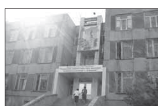
Ул. Тухачевского, 25. Общая площадь 51,5 кв.м.
