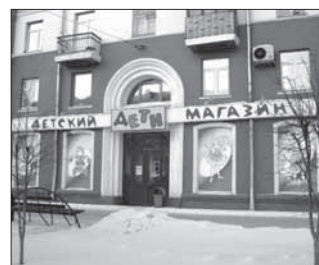
пр. Советский, 24 S=403,7 кв.м., (подвал 215,5 кв.м)
