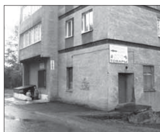
пр. Октябрьский, 56 S=109,3 кв.м., (подвал)
