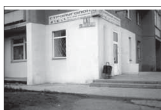
Просп. Шахтеров, 81. Общая площадь 121,4 кв.м.
