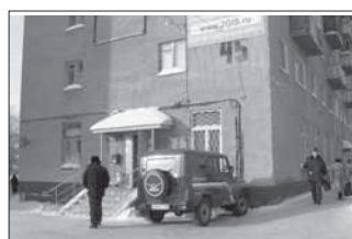
Просп. Шахтеров, 45. Общая площадь 121,4 кв.м.
