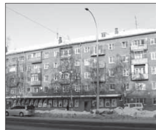
ул. Терешковой, 42 S=631,9 кв.м., (подвал 363,6 кв.м)
