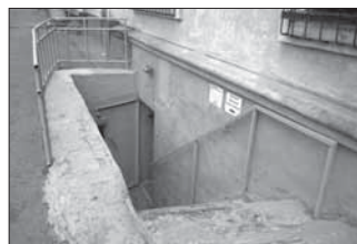
Ул. Островского, 33. Общая площадь 126,5 кв.м.
