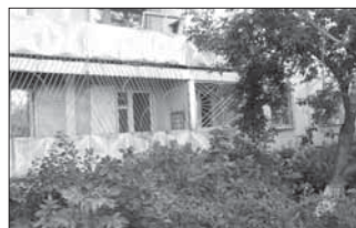
Бульв. Строителей, 6. Общая площадь 31 кв.м.
