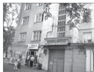
ул. 40 лет Октября, 8 S=175,3 кв.м., (подвал 86,6 кв.м)
