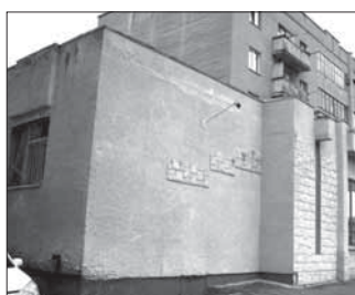
ул. Патриотов, 36 S=134,4 кв.м., (подвал)
