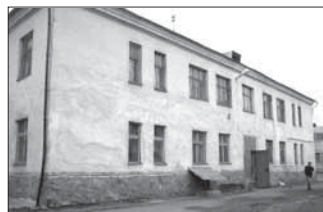
Ул. Каркасная, 10а. Общая площадь 155,3 кв.м.
