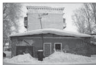
Ул. Черняховского, 3. Общая площадь 166,5 кв.м.
