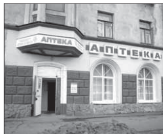
ул. Н.Островского, 27 S=271,5 кв.м., (подвал 178 кв.м)
