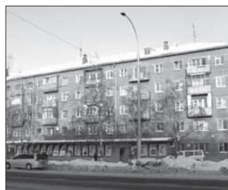
ул. Терешковой, 42 S=631,9 кв.м., (подвал 363,6 кв.м)
