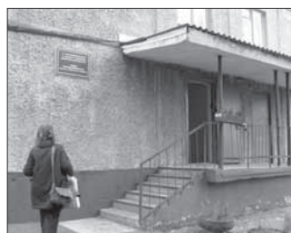
Ул. Институтская, 4. Общая площадь 108,0 кв.м.
