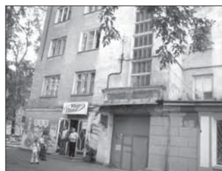
ул. 40 лет Октября, 8 S=175,3 кв.м., (подвал 86,6 кв.м)
