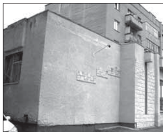
ул. Патриотов, 36 S=134,4 кв.м., (подвал)
