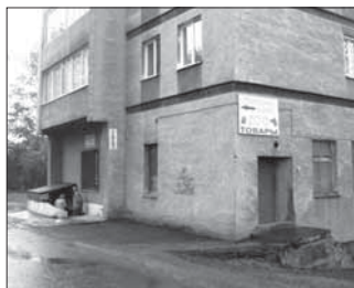
пр. Октябрьский, 56 S=109,3 кв.м., (подвал)
