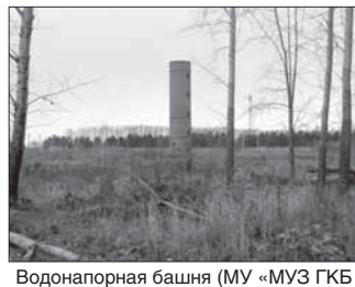
Водонапорная башня (МУ «МУЗ ГКБ № 11» и ул. Вахрушева, 2). Общая площадь 21,2 кв.м.
