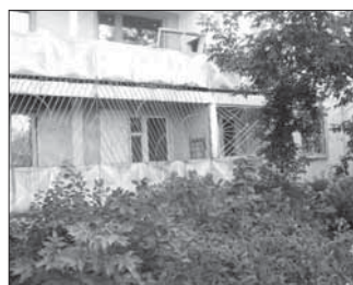
Бульв. Строителей, 6. Общая площадь 31 кв.м.
