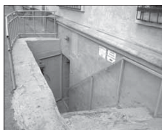
Ул. Островского, 33. Общая площадь 126,5 кв.м.
