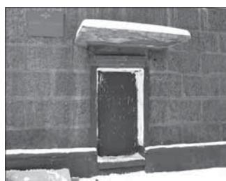
Ул. Островского, 31. Общая площадь 233,8 кв.м.
