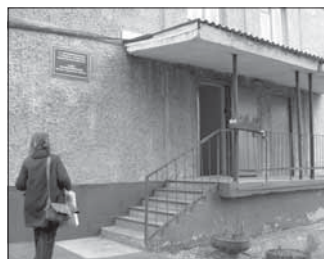
Ул. Институтская, 4. Общая площадь 108,0 кв.м.
