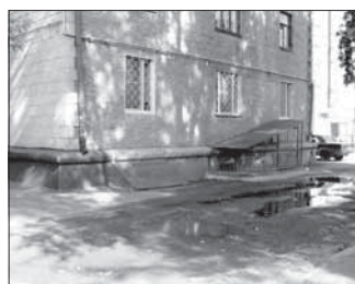
Ул. Весенняя, 22 (склад). Общая площадь 97,8 кв.м.
