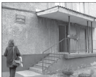
Ул. Институтская, 4. Общая площадь 108,0 кв.м.
