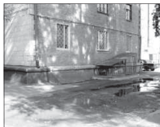
Ул. Весенняя, 22 (склад). Общая площадь 97,8 кв.м.
