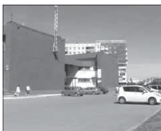
Ул. Марковцева, 20 «б» (чердак). Общая площадь 152,0 кв.м.
