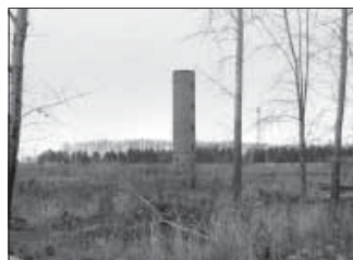
Водонапорная башня (м/у МУЗ «ГКБ № 11» и ул. Вахрушева, 2). Общая площадь 21,2 кв.м.
