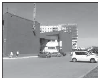
Ул. Марковцева, 20 «б» (чердак). Общая площадь 152,0 кв.м.
