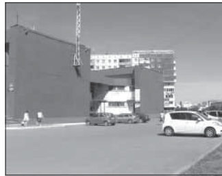
Ул. Марковцева, 20 «б» (чердак). Общая площадь 152,0 кв.м.
