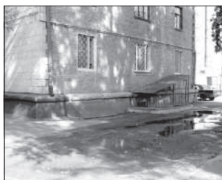
Ул. Весенняя, 22 (склад). Общая площадь 97,8 кв.м.
