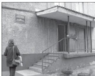
Ул. Институтская, 4. Общая площадь 108,0 кв.м.
