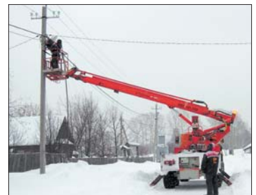
Монтаж СИП и уличного освещения на одной опоре.
