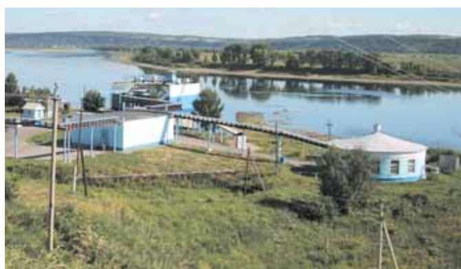
На фото: реконструированная насосная станция первого подъема, 2009 год.
