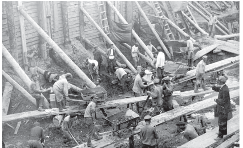
На фото: строительство площадки под эвакуированный с запада страны завод.
