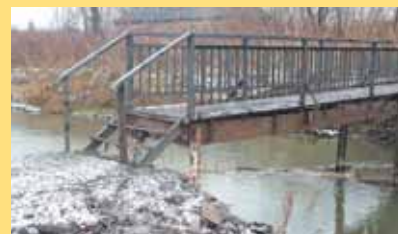
На фото: отремонтированный мостик. Сквозь кусты видно дом Галины Горчуковой.
