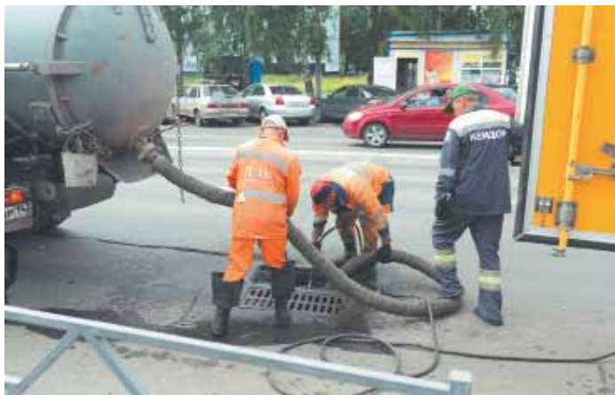
На фото: дорожники проводят техническое обслуживание сетей ливневой канализации.
