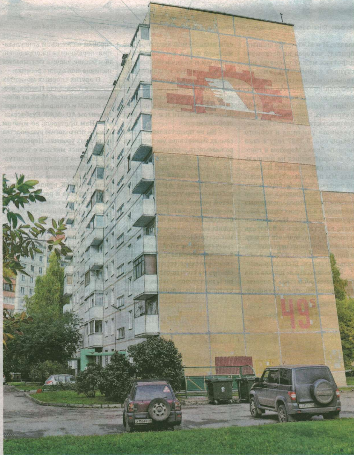
На фото: один из домов в Ленинском районе, возведенных силами комсомольско-молодежного строительного отряда, украсила эмблема МЖК «Аист».
