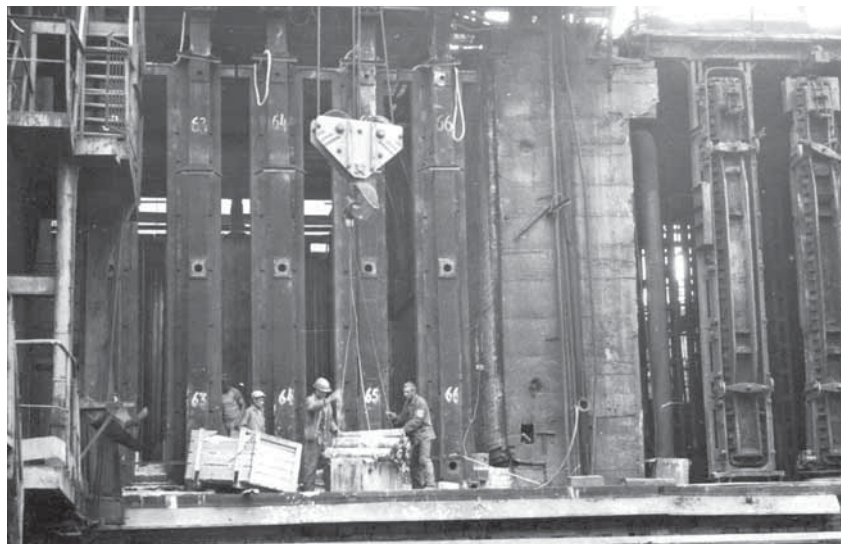
На фото: кладка протенков 4-й коксовой батареи Кемеровского коксохимического завода, 1944 г.
