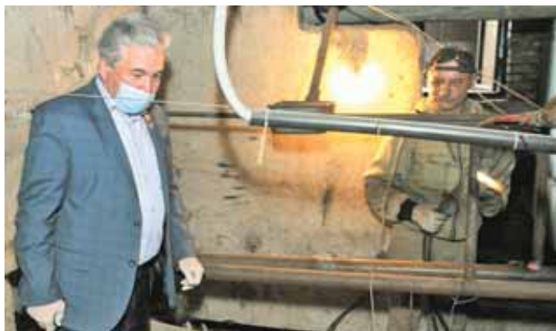
На фото: Юрий Скворцов лично проверяет ход ремонтных работ в жилых домах Кемерова.
