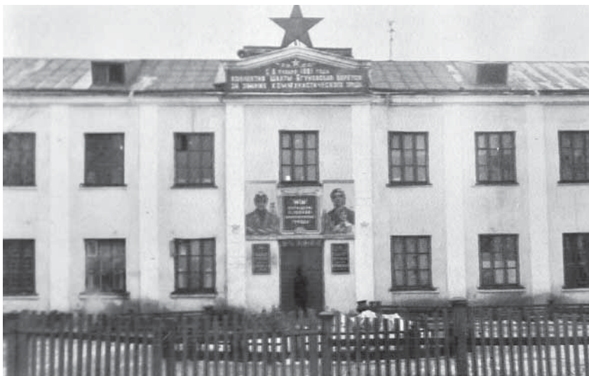
На фото: здание шахтоуправления (архив музея «Память»). Ни одно из наземных сооружений «Ягуновской» не сохранилось.
