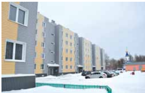
На фото: на Белозерной вновь растут новостройки.
